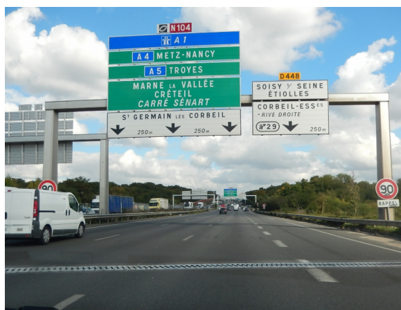
Illustration 19: Élargissement de la RN104, source DDT91
