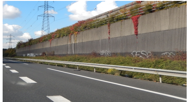
Illustration 15: Écran béton, Source : DDT91
